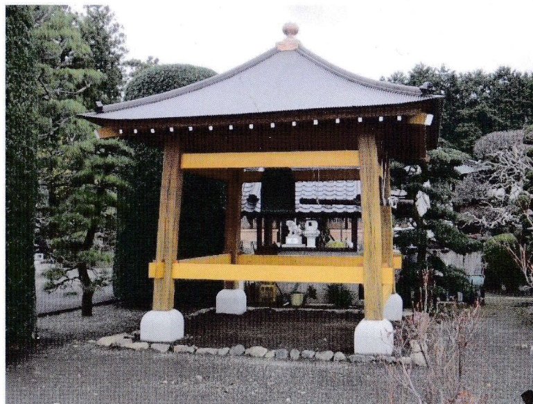
写真1 改修された鐘楼全景
